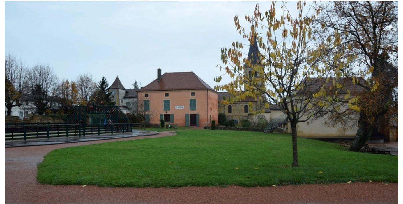
Centre-bourg de Fleury-la-Montagne structuré autour de son parc et de ses équipements (Mairie, Agorespace, bibliothèque...)
