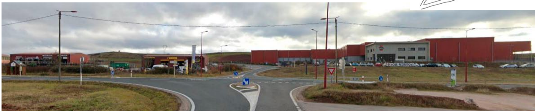
Exemple de bâtiments dont la colorimétrie est à dominante «rouge rougier» - ZA Saint-Pierre - Rebourguil
