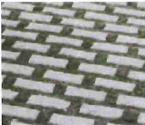
Pavage en béton avec ouvertures de drainage
