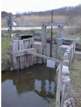
Photo 3 : porte à flots du marais de Ver-sur-Mer
