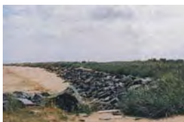
Photo 2 : enrochement à Meuvaines
