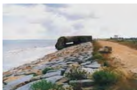
Photo 10 : « cordon-digue » de la Brèche de Bisson
