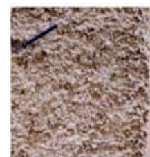
Exemple d'enduit brut de projection dit rustique Mise en œuvre jetée ou broyée
