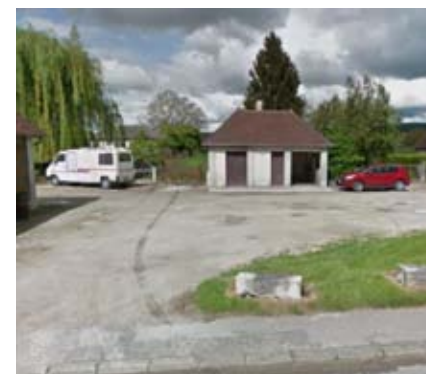
ELEMENT BATI N°9 : Alambic : rue du Bois
