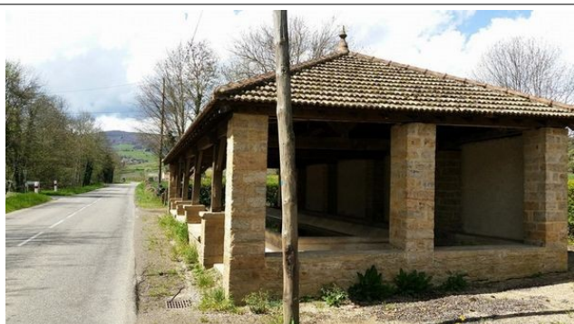
51. 15. Lavoir datant du 19ème siècle avec bassin rectangulaire en pierre de taille
