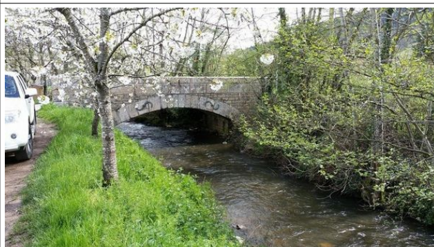
53. 14b. Exemple de pont de pierres permettant l'accès aux Essertaux
