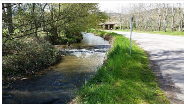
52. La petite grosne, sa ripisylve préservée côté espaces agricoles, ses ouvrages (seuil, franchissement...)
