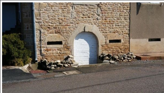
30. Voûtes en pierre de taille
