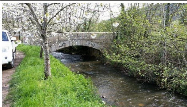
14a à 14f. Ponts en pierre
