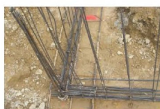
Nœud de chaînage - Continuité mécanique
