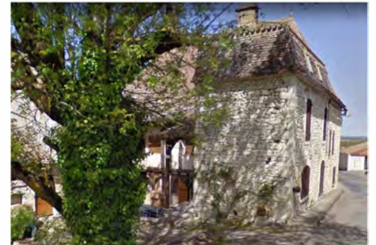
6StEut Ensemble immobilier remarquable Parcelle A 0925
