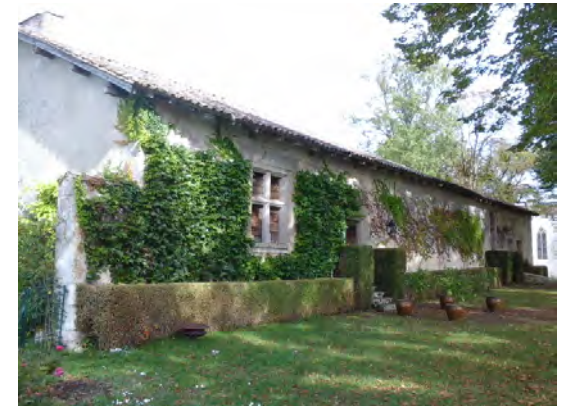
30Cah Corps de bâtiment de l'ancien château Parcelle A 0088
