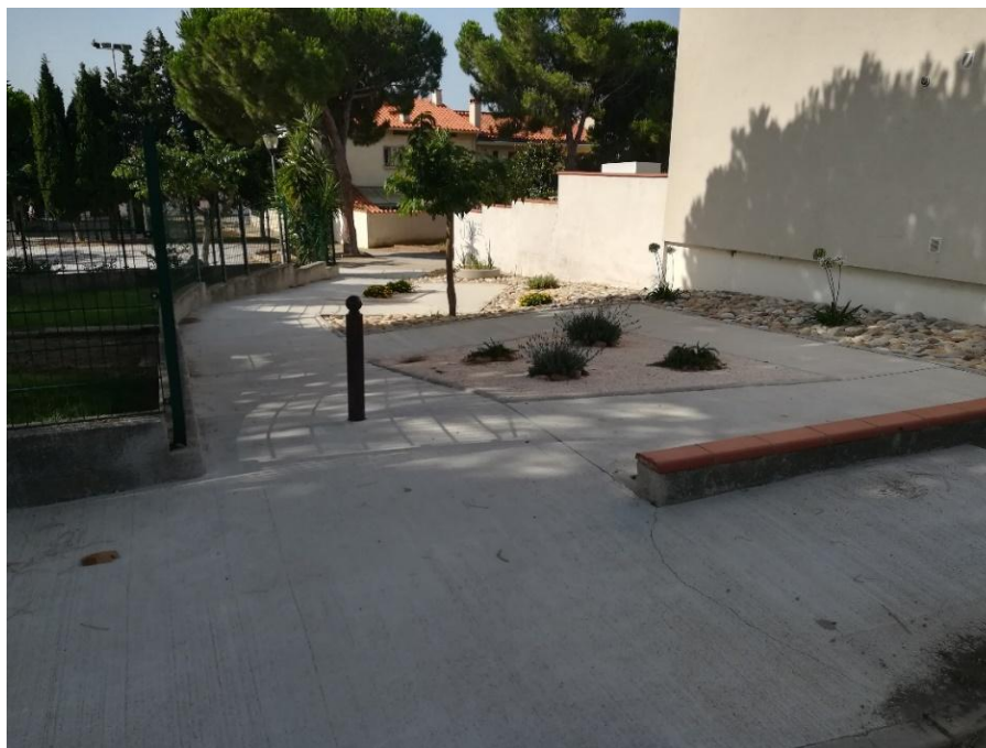
TRAVAUX RAMPE PMR « THÉÂTRE JEAN PIAT »
