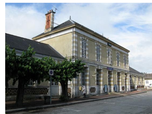
Gare TER de Le Buisson-de-Cadouin
