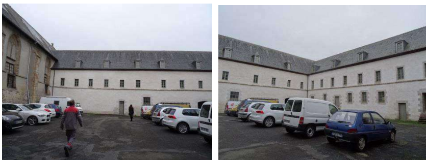
Cour des Jacobins (non protégée MH)
