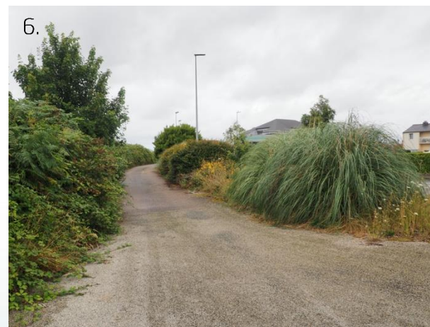
Voie d'accès à partir du parking vers le Centre Feu Vert
