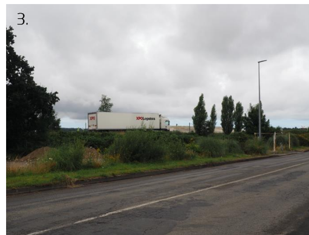
Vue du site et de la RN12 depuis l'Allée des Peupliers
