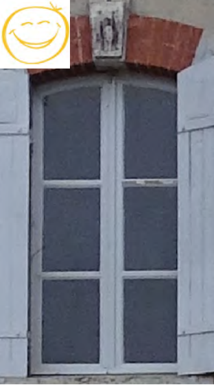
Fenêtre en bois à deux battants avec petits bois décomposant en 3 carreaux
