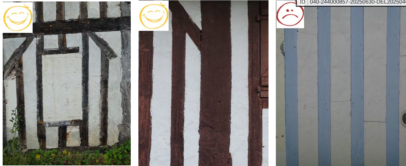
Détails des colombages et remplissage en torchis enduits
