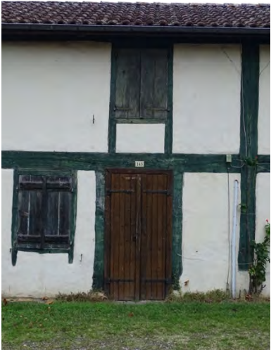
Remplissage de colombage en « barrons » Remplissage et colombage partiellement masqués par un enduit
