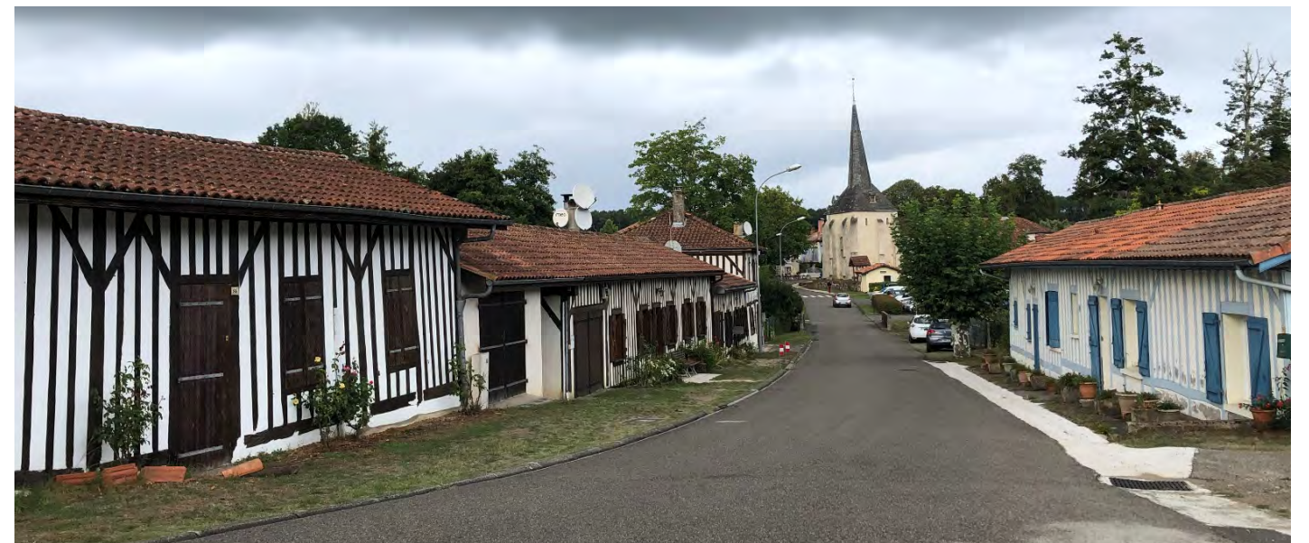
Entrée de bourg depuis le Sud (RD 105) : l'alignement des façades encadre la perspective valorisant le point de vue sur l'église
