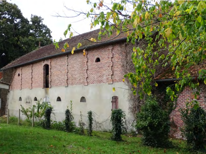
Dépendance « Maison Sanguina » Route du moulin Vieux
