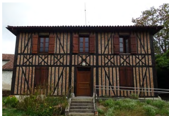
Façade « à barrons », ancien presbytère au sud de l'Église
