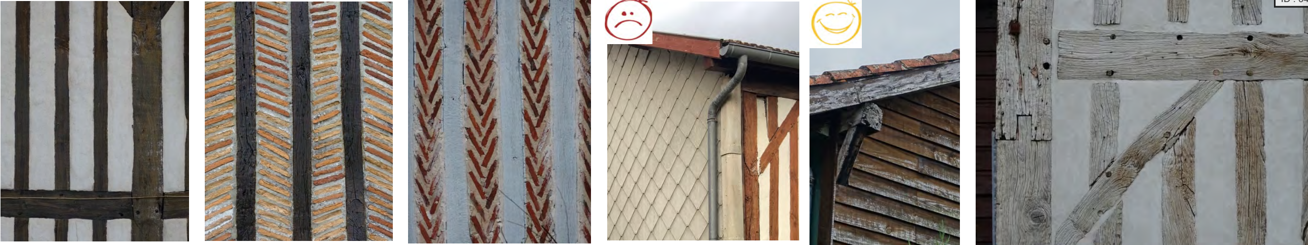
Remplissage de colombage enduit Remplissage en « barrons » non enduits Remplissage en « barrons » à motif en feuille de fougère Doublage des murs à pans de, ... , en bardage bois horizontal bois en plaques de fibra-ciment
