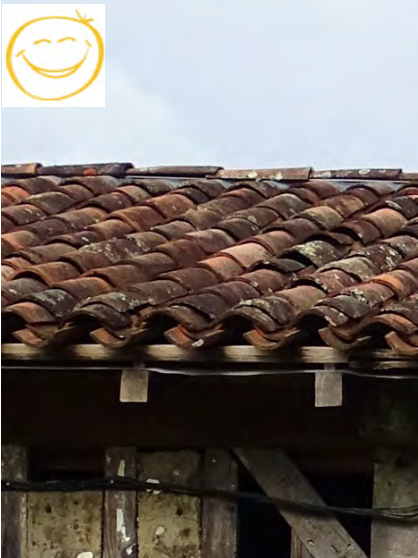
Restaurer les couvertures d'origine en tuiles « Canal »
