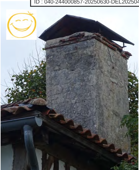
Souche de cheminée à conserver
