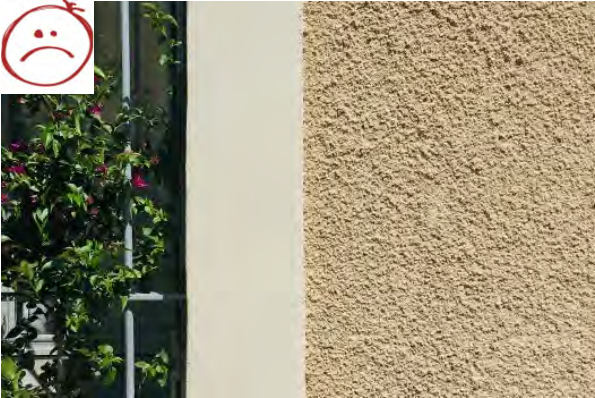
Éviter les finitions d'enduit projeté
