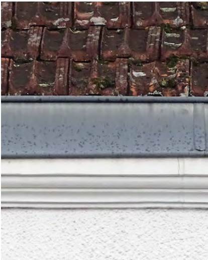
Chêneau en zinc sur corniche en pierre
