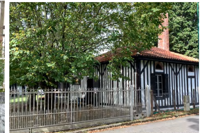
Grille en fer forgé toute hauteur de la fondation Boucau
