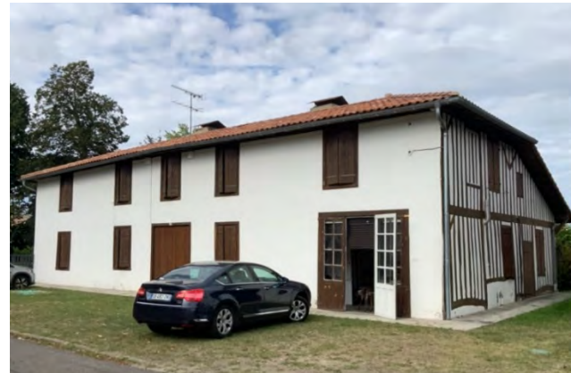
Façade de Maison à pans de bois enduite Rue de la Mairie
