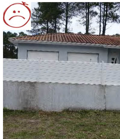
Mur bahut avec palissade PVC
