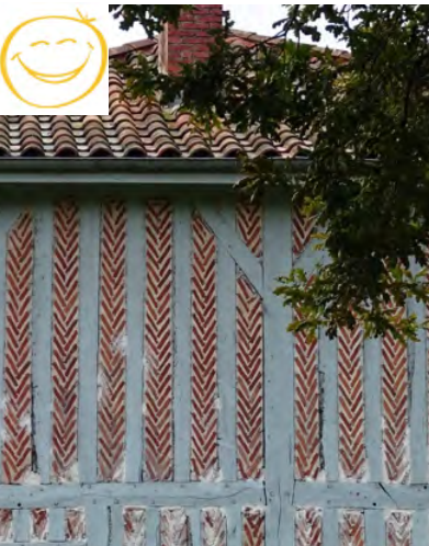
Remplissage de colombage en « barrons » Remplissage et colombage partiellement masqués par un enduit
