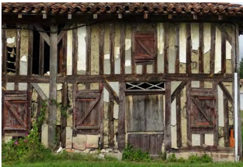
Soubassement maçonné enduit, pans de bois et remplissage en torchis avec enduit de protection
