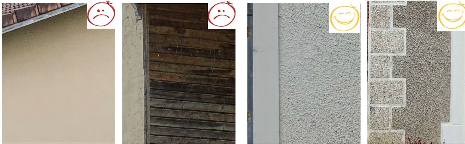
Conserver les chainages d'angle
