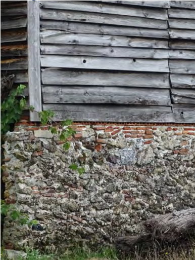
Soubassement de Grange en bois
