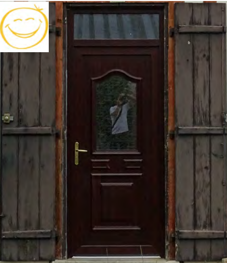
Volets de porte d'entrée à deux battants avec barres sans écharpe
