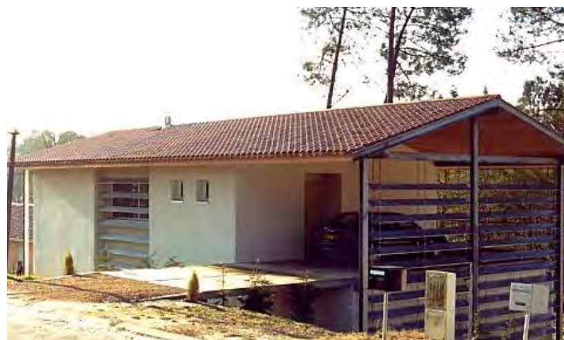
Maison type longère R. LAMANIVE & V. POEYMIRROO architectes
