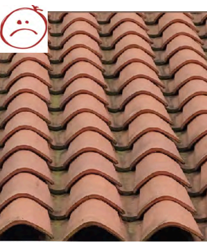
Eviter less tuiles « canal » à emboîtement
