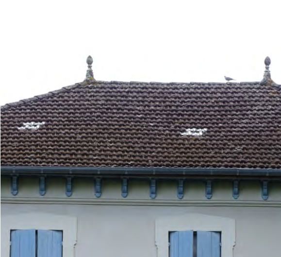
Avant toit avec consoles en bois peint
