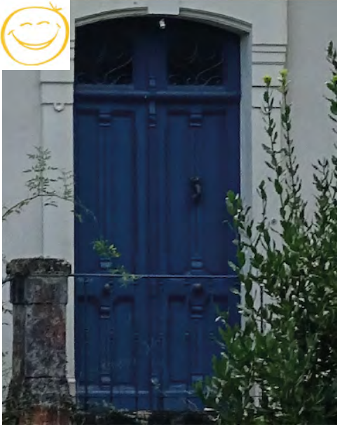
Porte pleine en bois avec imposte
