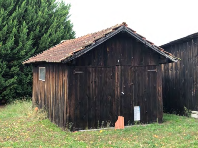
Annexe tranformée en garage, rue des Tilleuls
