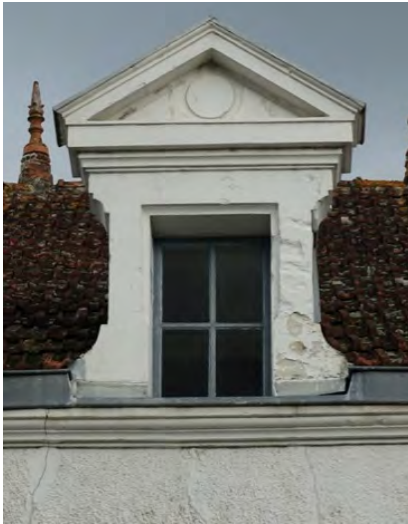
Lucarne à l'aplomb de la façade
