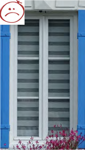
Fenêtre en PVC à deux battants avec petits bois dans vitrage
