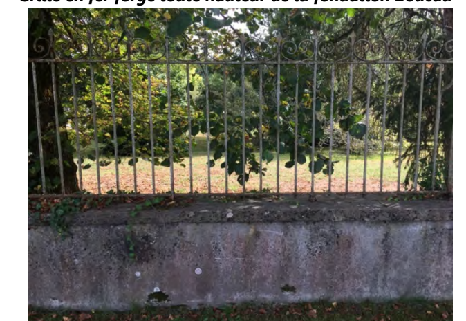
Grille sur muret maçonné « maison Sanguina »
