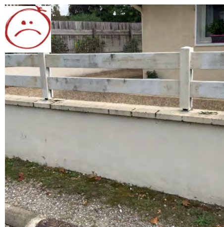
Mur bahut avec lisses horizontales
