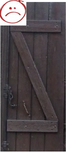
Volet fenêtre en bois avec barres et écharpe
