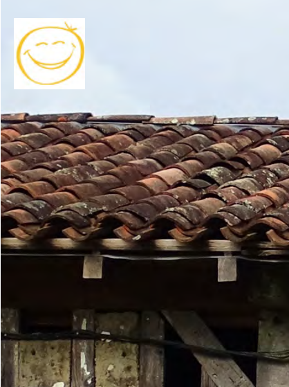
Restaurer les couvertures d'origine en tuiles « Canal »
