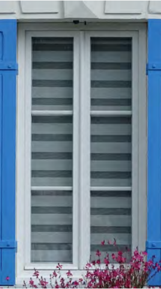
Fenêtre en PVC à deux battants avec petits bois dans vitrage
