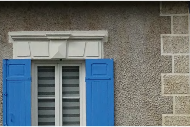
Jeux d'enduits « fouettés » et encadrements de baies en pierre
