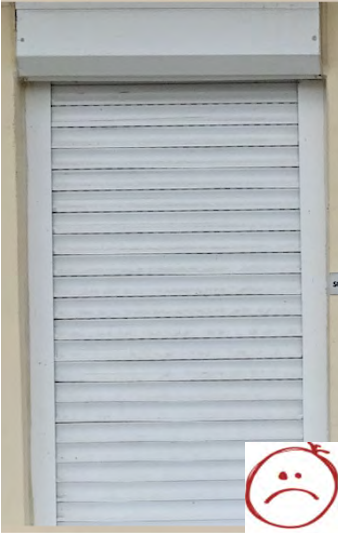
Volet roulant en PVC, avec coffre apparent
