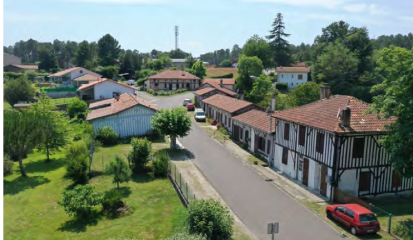
Vue vers le Sud depuis le Vignac
