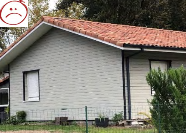
Éviter les faux pans de bois en référence à la « Landaise » et le Bardage horizontal en matériaux composites
