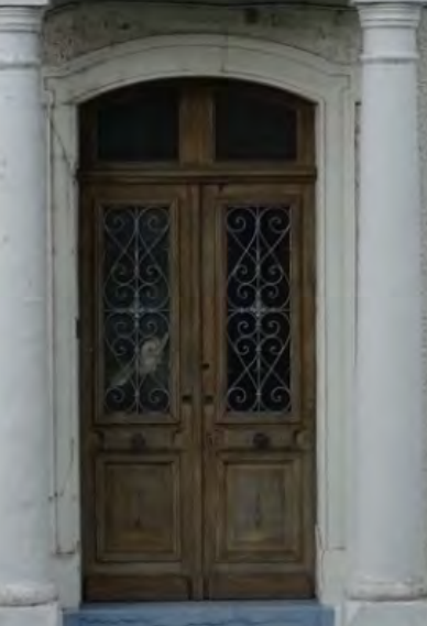
Porte d'entrée avec grilles et imposte
