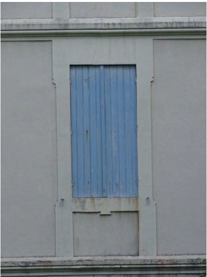
Corniches et encadrements de baies
