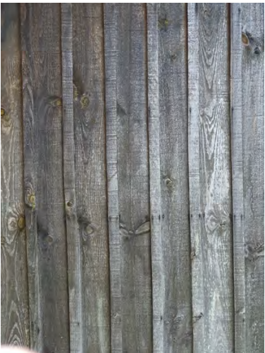
Bardage : Voliges plus couvre joints Protection de la façade par un avant-toit généreux
