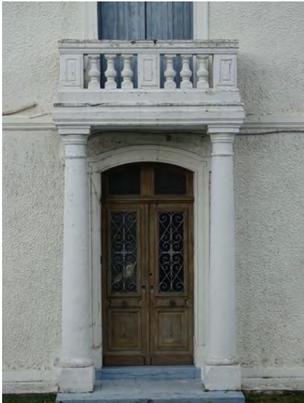
Balcon à balustre en pierre sur colonnes
