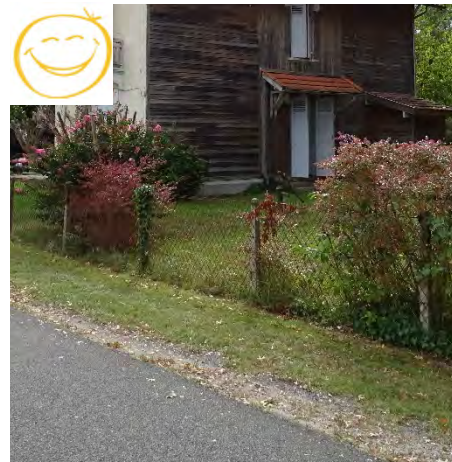
Grillage avec arbustes en discontinu
