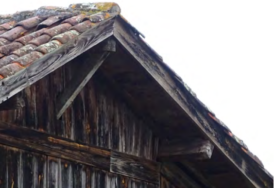
Bardage : Voliges plus couvre joints Protection de la façade par un avant-toit généreux
