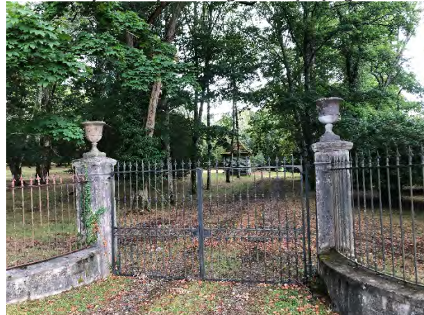
Muret avec piles en pierre et grille en fer forgé
