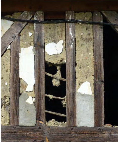
Soubassement maçonné enduit, pans de bois et remplissage en torchis avec enduit de protection
