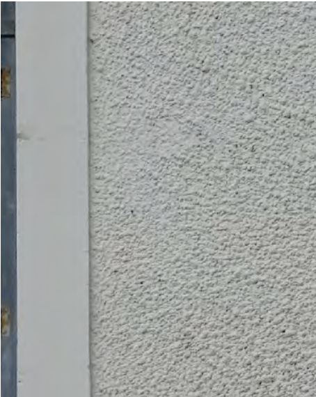
Restituer les enduits « fouettés »
