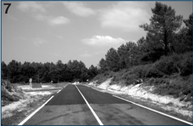
6/7. La voie de raccordement de l’échangeur central à la route de Pontonx. Sur la gauche, les terrains Etat sont en attente d’un aména- gement paysager.
