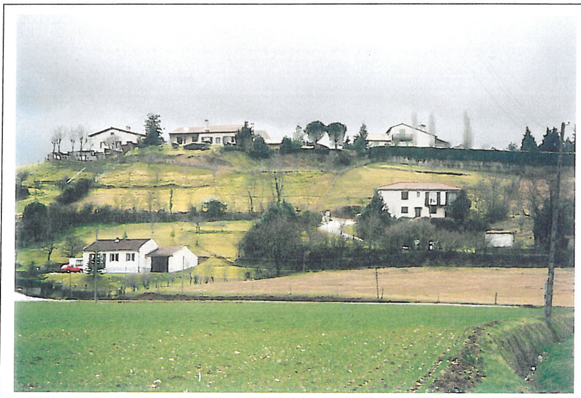
Photo 13 : Lieu-dit Lameillé Haute. Photo prise le 21 février 2000. Secteur pavillonnaire diffus affecté sur les plus fortes pentes de mouvements lents de terrain subactuel. Une couverture végétale uniforme stabilise ce versant, mais sa fragilité est une réalité. La maison en bas à gauche, semi-enterrée, est particulièrement exposée aux mouvements de terrain dans ce type de formation marneuse.
