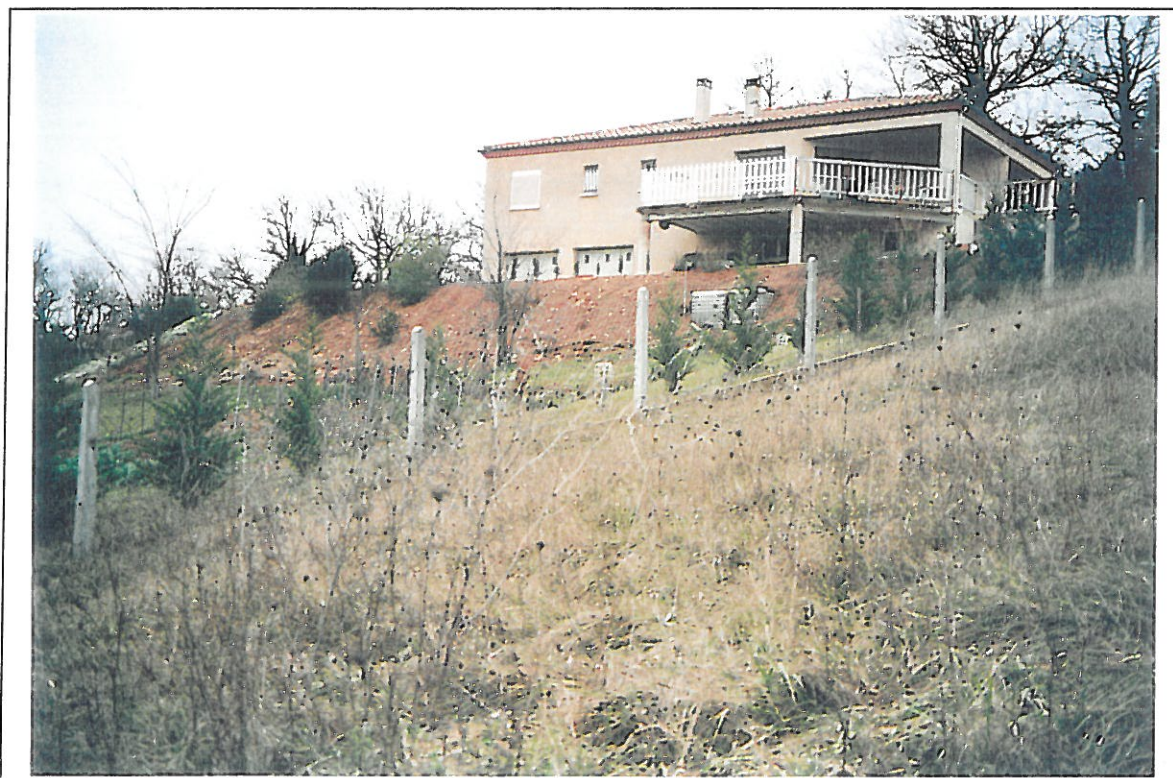
Photo 5 : Type d'aménagement construit sur une plate-forme réalisée par un mouvement de déblais-remblais sur une pente entre 10 à 15 %. Si les fondations aval ne sont pas réalisées à une profondeur suffisante le risque d'une dessiccation existe. Les déblais restent peu stables et le risque d'affouillement est réel..
