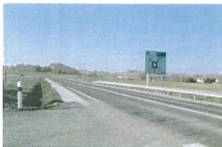
Accès à la rocade : échangeur avec la route de Lavaur au Nord de la zone
