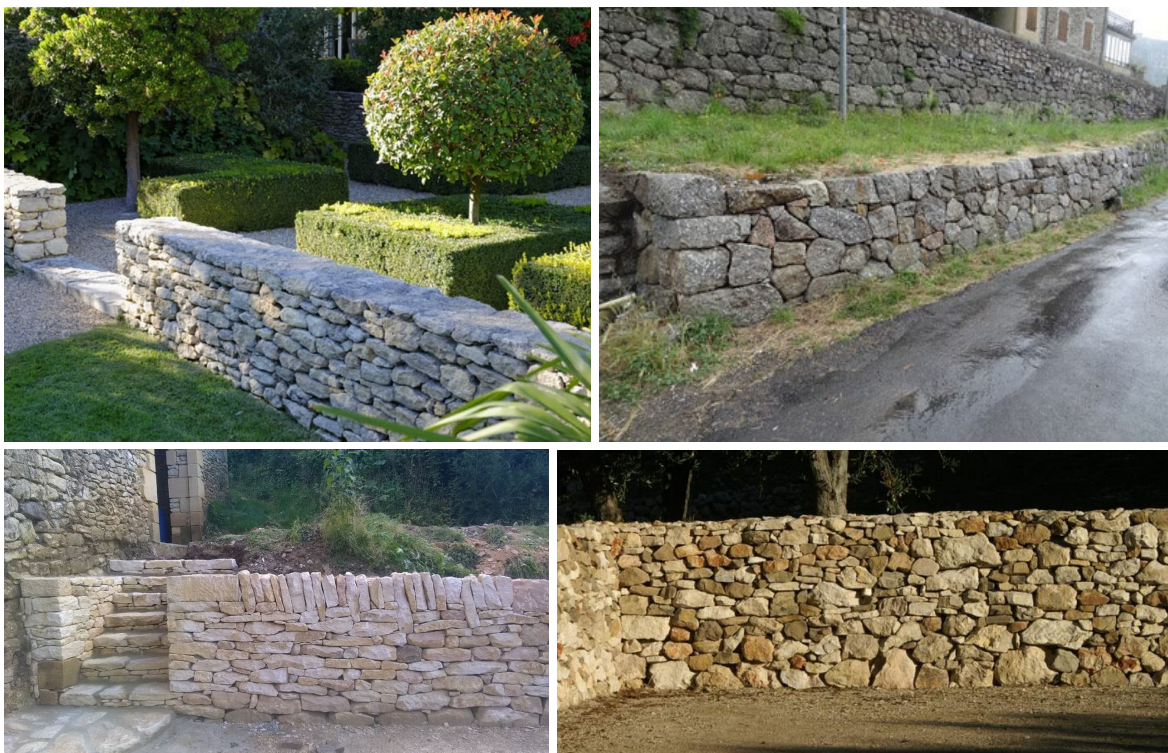
Exemples de murs en pierre sèche autorisés bien que sans accompagnement végétal
