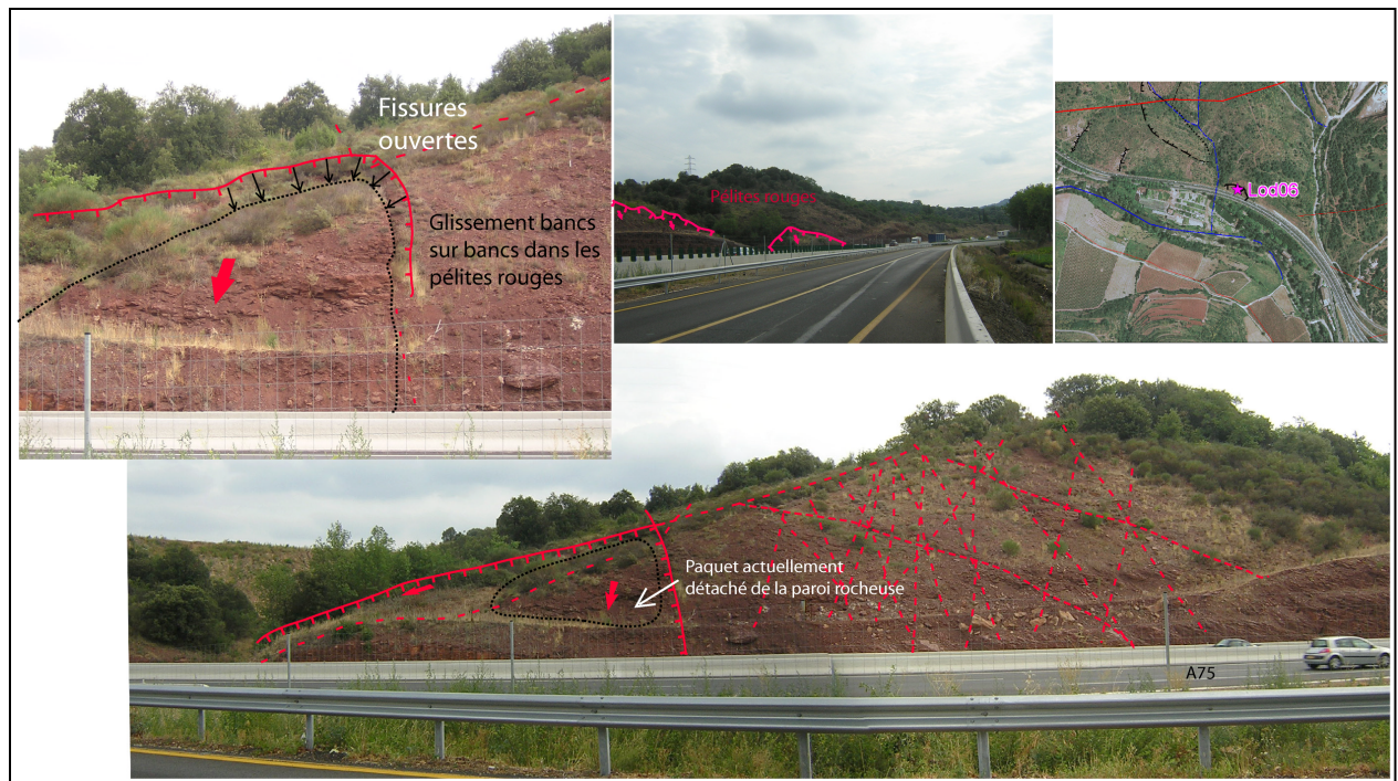
Figure 4 : Eboulements/Chutes de blocs le long de la A75, au niveau du lieu dit "Le Capitoul". Pélites permo-triasiques affectées par un ensemble de fissures ouvertes qui délimitent des blocs de taille souvent décamétrique qui se trouvent en équilibre instable.
