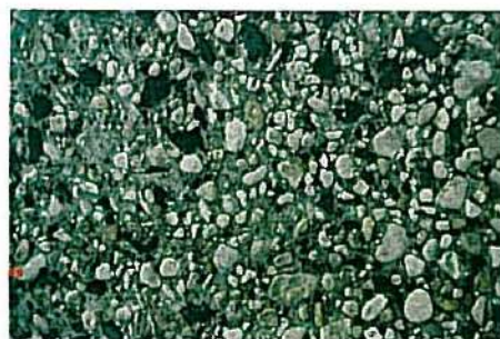
à gauche : revêtement en galets Ci contre à gauche : béton désactivé à gros granulats
