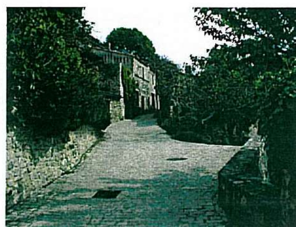
à gauche : revêtement en pierres naturelles dans une ruelle Au centre : caniveau en pierres et bords en béton désactivé Ci contre : placette en pierres
