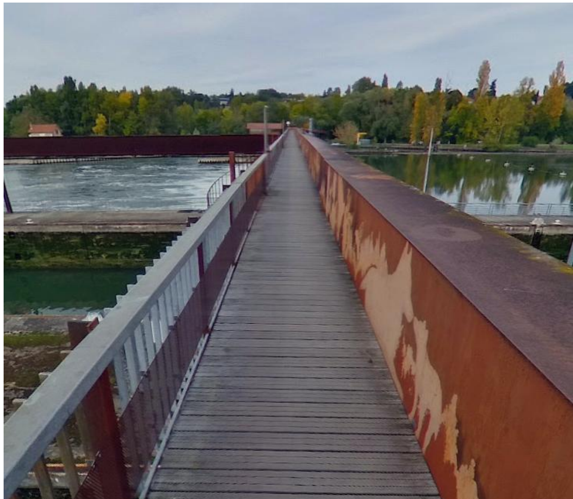
PASSERELLE ENTRE BOIS-LE-ROI ET CHARTRETTES - SOURCE : GOOGLE MAPS
