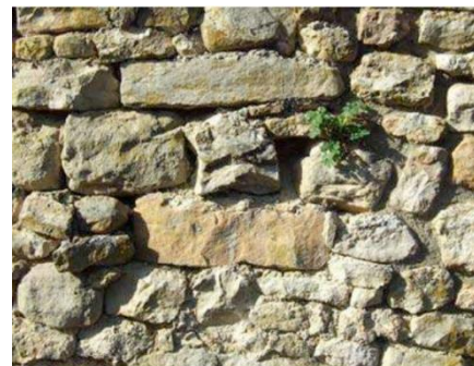
A gauche, un mur en moellons rendu vulnérable par le décroutage de l'enduit ancien qui laisse les côtés des pierres à l'air libre et par quelques reprises au ciment. A droite, un mur en moellons protégé par un enduit à pierre-vue mis en œuvre avec des méthodes et matériaux traditionnels.
