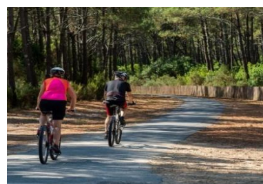
AMENAGEMENT D'UN CHEMIN EXISTANT, ICI ANCIEN CHEMIN FORESTIER DANS LES LANDES
