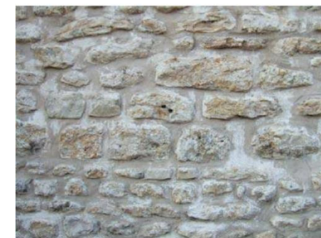
A gauche, un mur en moellons rendu vulnérable par le décroutage de l'enduit ancien qui laisse les côtés des pierres à l'air libre et par quelques reprises au ciment. A droite, un mur en moellons protégé par un enduit à pierre-vue mis en œuvre avec des méthodes et matériaux traditionnels.
