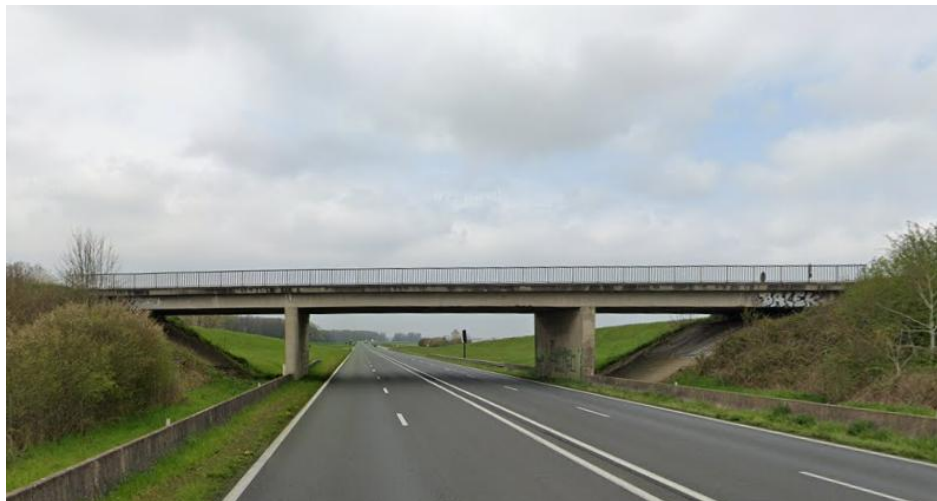
FRANCHISSEMENT DE LA D637 SUR LA D64 A CHAILLY-EN-BIERE - SOURCE : GOOGLE MAPS
