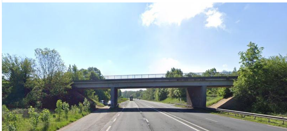
FRANCHISSEMENT DE LA D637 SUR LA D372 A CELY - SOURCE : GOOGLE MAPS
