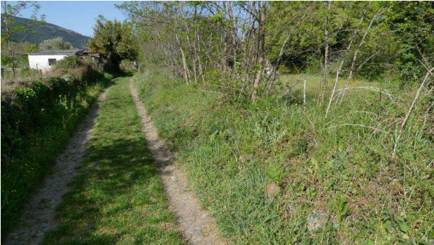
Photographie 8 : Muret envahi de broussailles au Nord de l'aire d'étude rapprochée
