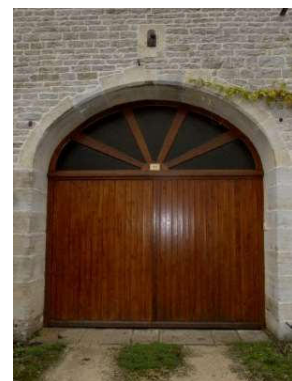
Porte pleine et imposte vitrée - Arc cintré
