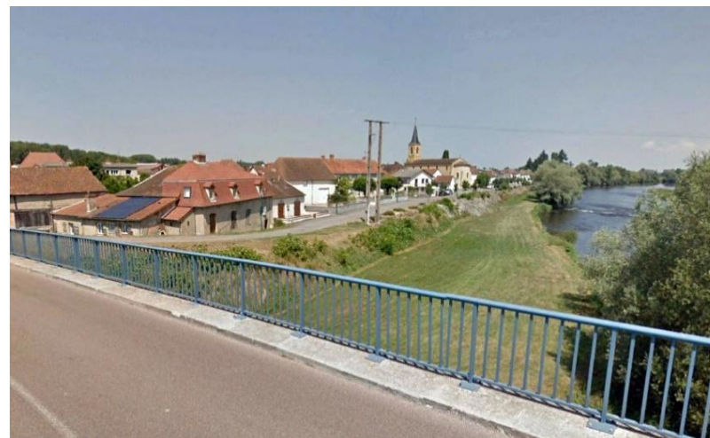
Village de bord d'eau – Chambilly en bord de canal
