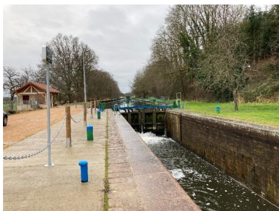
Ecluse du canal à Chambilly
