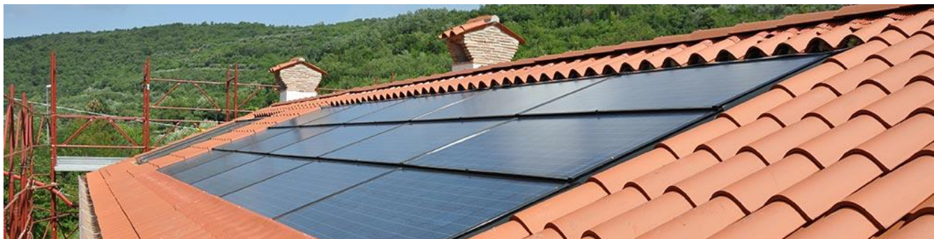
Panneaux intégrés dans l'épaisseur de la toiture.
