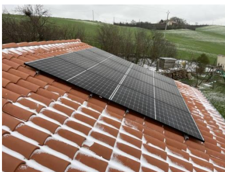
Panneaux en surépaisseur de 20 cm maximum par rapport au plan de toiture.
