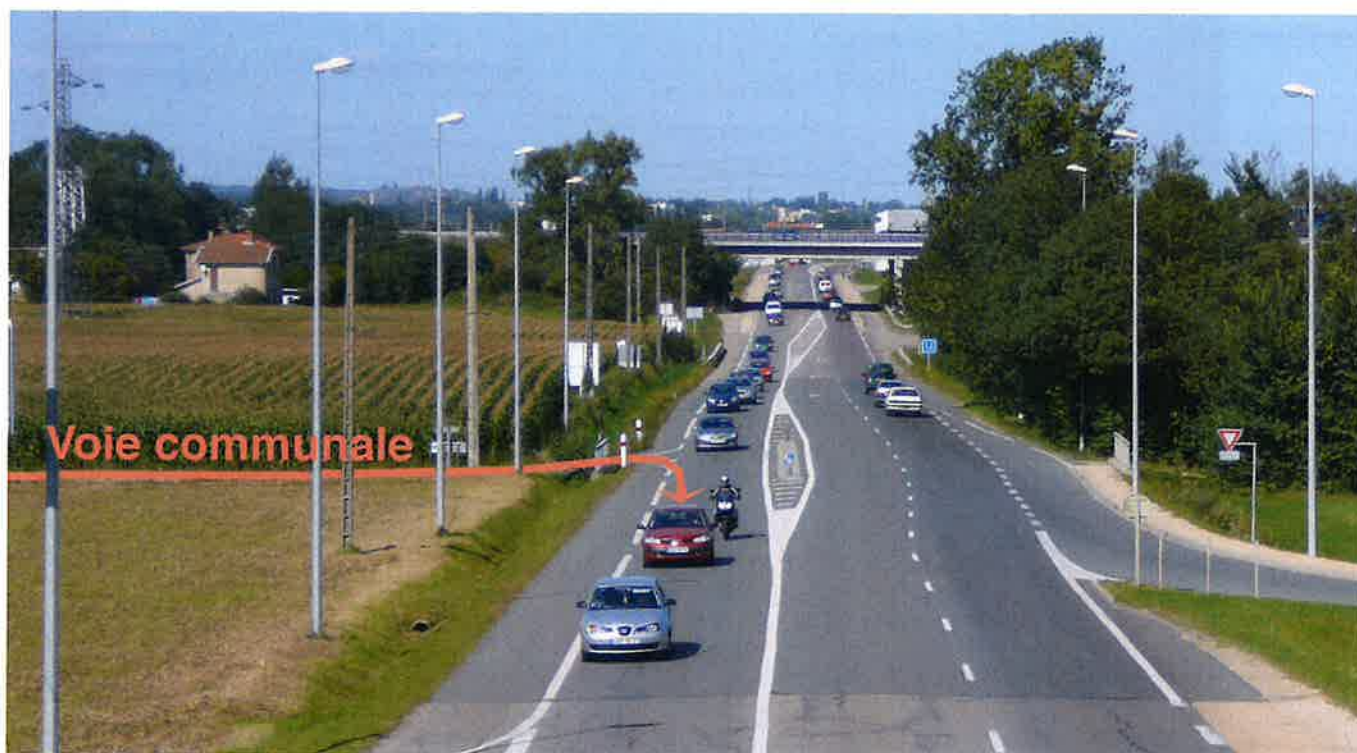
↪ Depuis le pont d'accès à la zone des Bouchardes
