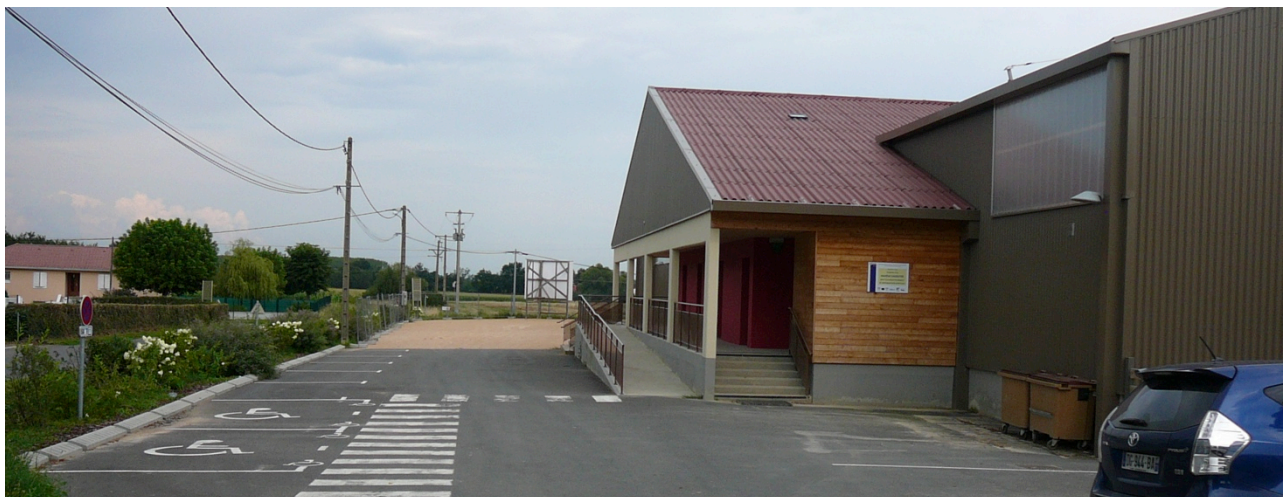
Le parking le long du chemin du Roy de Croix
