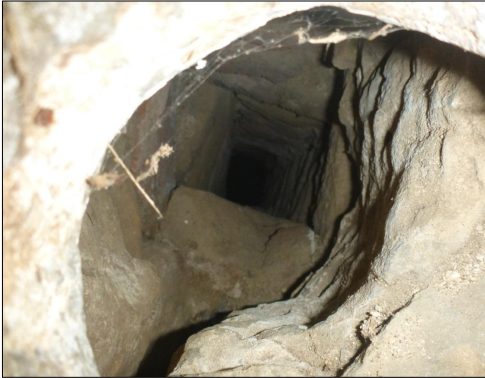
Photo 31 : Intérieur du puits Saint-Laurent P23
