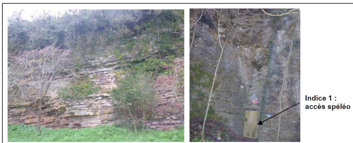
Figure 5 : Vue des calcaires à Gryphées (à gauche : aux Menaults, commune de Change, et à droite : au hameau de Mazenay)
