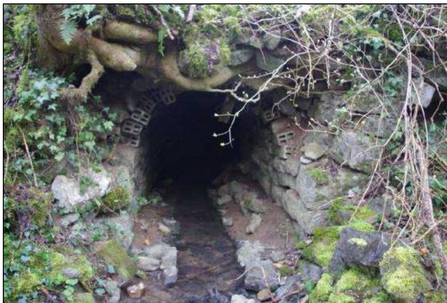
Figure 27 : Vue de la galerie d'écoulement du Créot (cliché INERIS)
