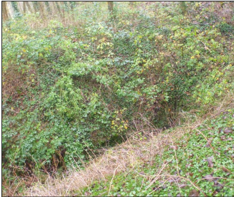
Photo 1 : Tranchée d'accès de la galerie des Menaults G8
