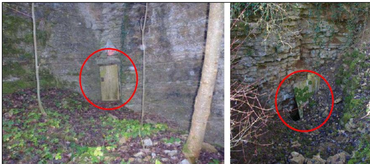
Figure 30 : Vues d'accès « spéléos » (à gauche : la Mine de Mazenay (indice 1), et à droite : la Mine de Change (indice 17))
