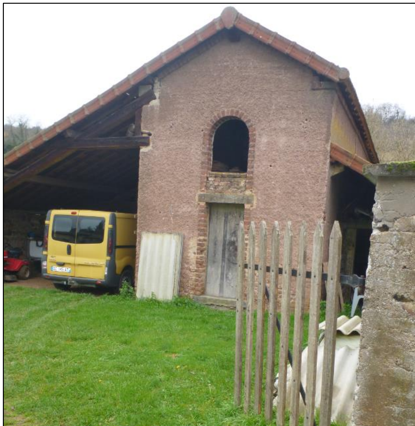
Photo 32 : Bâtiment renfermant le puits Saint-Laurent P23
