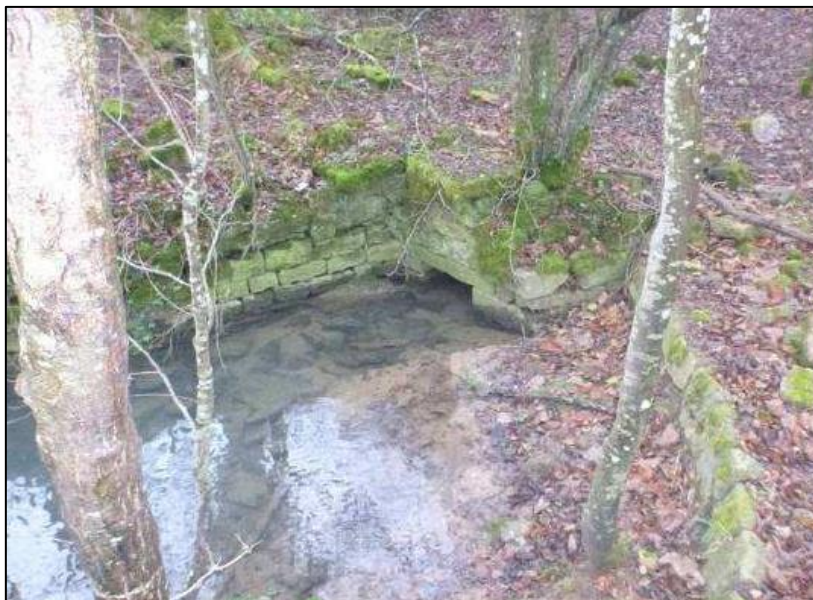
Figure 29 : Vue de la principale galerie d'écoulement G18 de Change (cliché INERIS)
