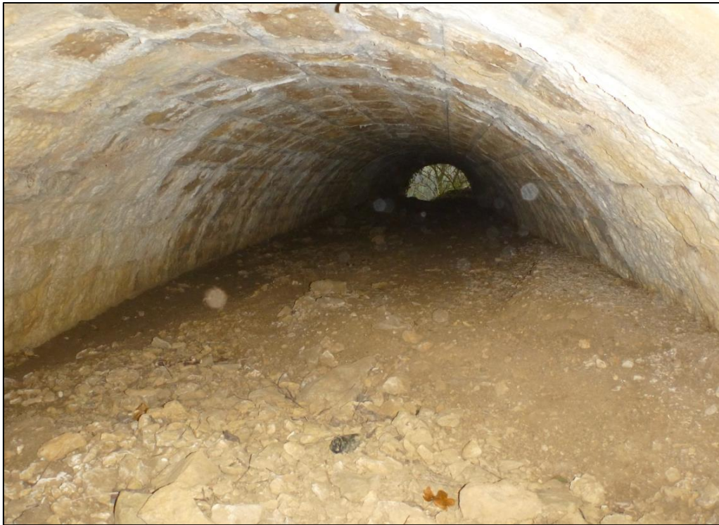
Photo 21 : Galerie Sainte-Clémence aval G35 (sous voie ferrée)
