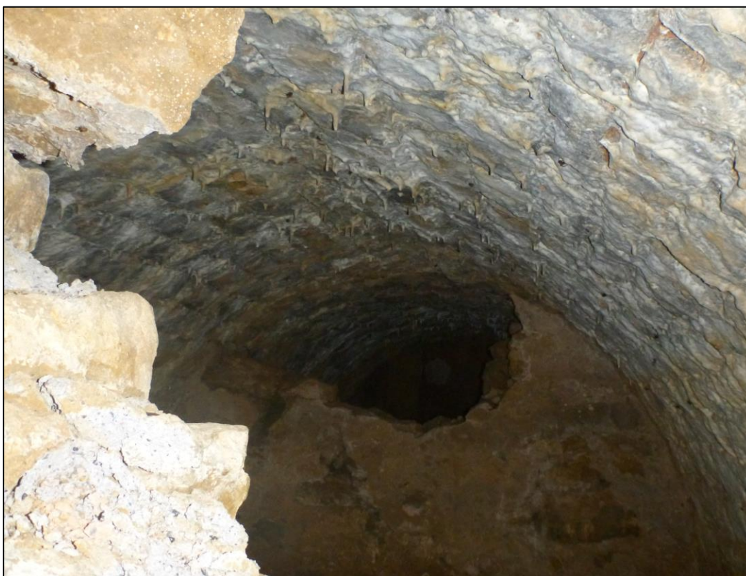
Photo 20 : Galerie Sainte-Clémence amont G34 (côté travaux)
