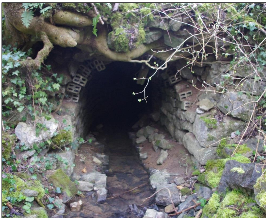
Photo 17 : Galerie d'écoulement du Créot G22
