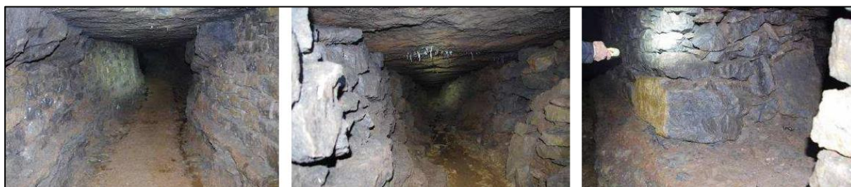
Figure 13 : Photographies de galeries centrales murées
