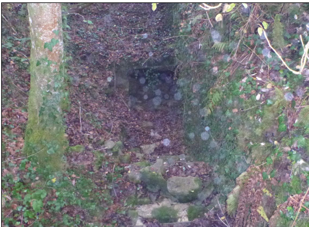
Photo 19 : Galerie Sainte-Clémence amont G34
