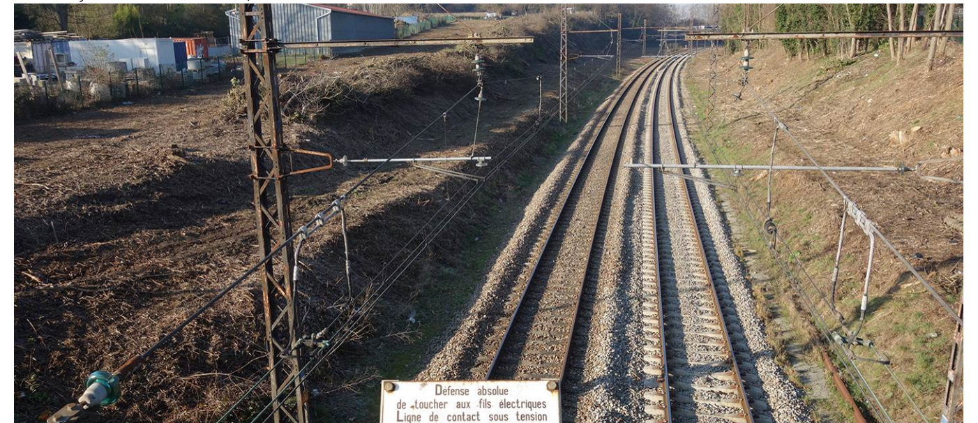
3.- Talus ferré Butte-Chaumont depuis le pont de la RD59
