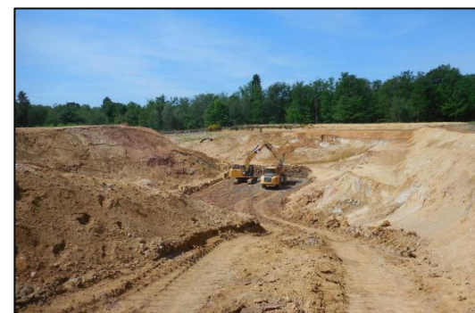
Carrière de SARL VIPA. Source : dossier de demande d'autorisation de renouvellement et d'extension de la carrière, juillet 2018
