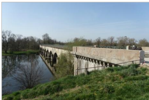
Pont-canal de Digoïn
