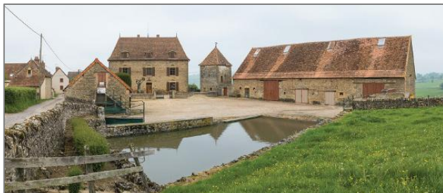
Saint-Julien-de-Civry, La Noue (ferme d'embouche datant du milieu du XVIII e siècle)
