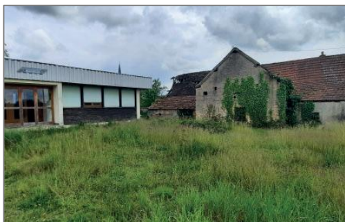
Friche de l'ancienne menuiserie à L'Hôpital-le-Mercier (Uf2)
