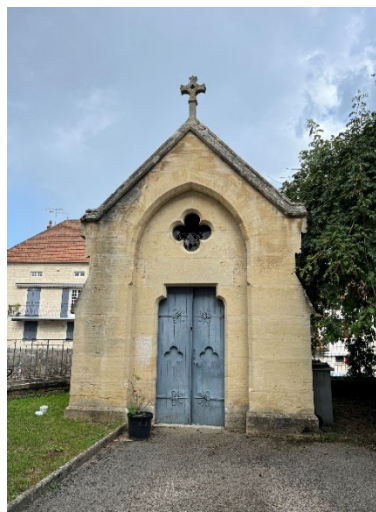
Chapelle de l'ancien hôpital, rue Pasteur ©BE-AUA
