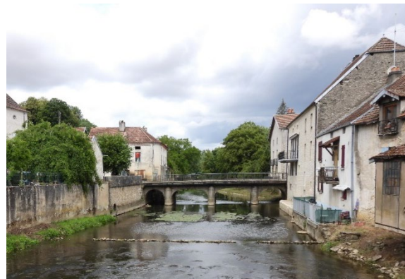
Pont sur le Salon © Atelier Atlante
