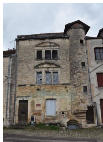
Figure 8 – Maison du XVI e siècle dite Maison Espagnole place des Halles
