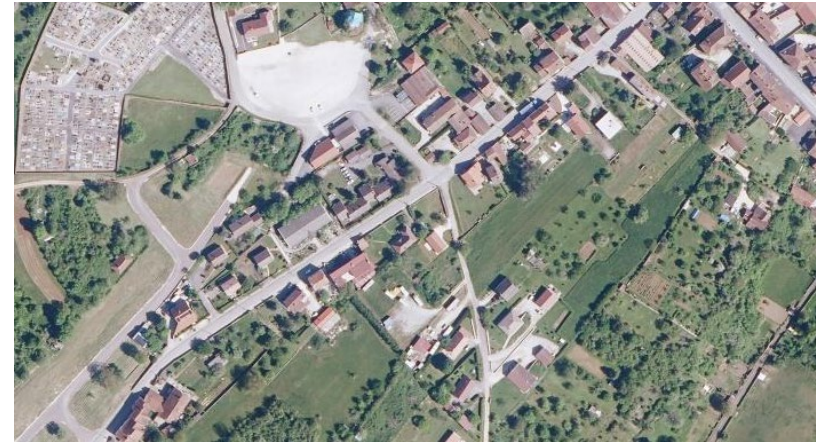
Avenue Carnot, alternance tissu pavillonnaire et bâtiments d'activités ©geoportail
