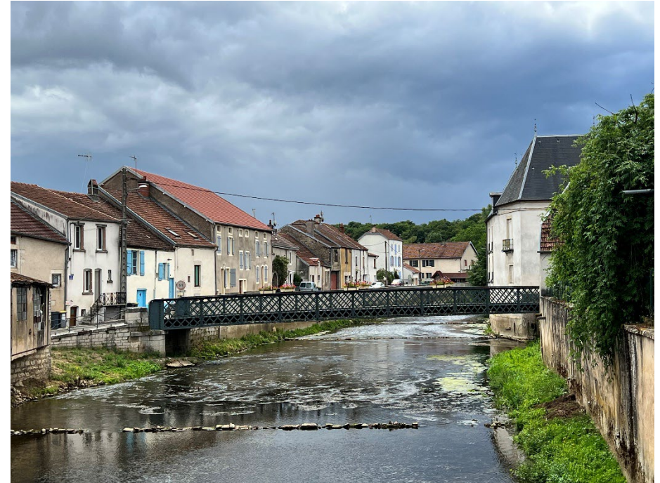
Passerelle sur le Salon ©BE-AUA
