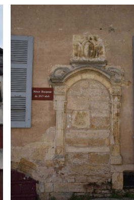
Figure 7 - Détail Maison du XVI e siècle 11 place des Halles
