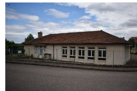
Figure 22- Ancienne école rue des Annonciades
