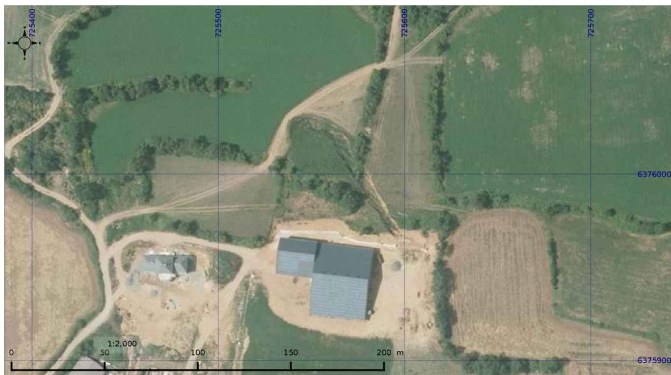
Fig. 5: glissement de terrain voisin: photographies aériennes
