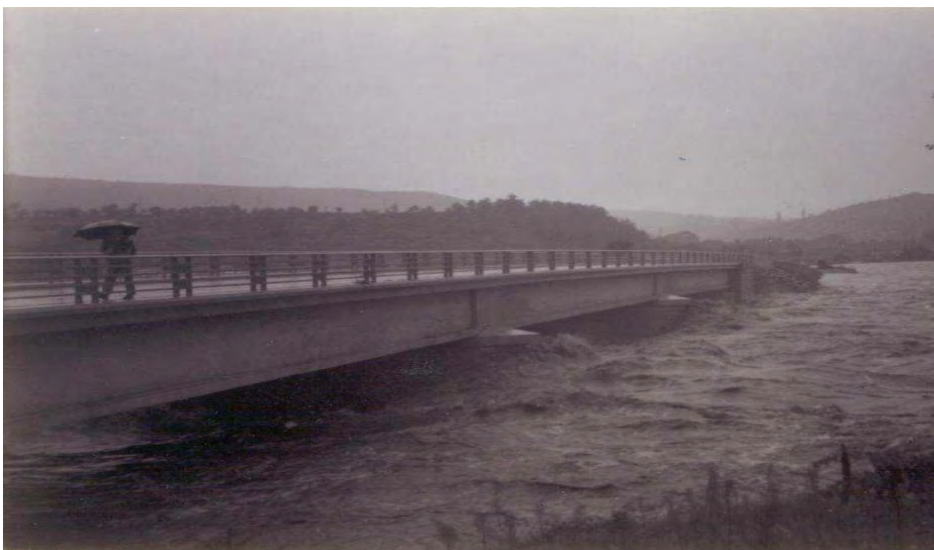
Crue octobre 1958 - amont pont de la Beaume
