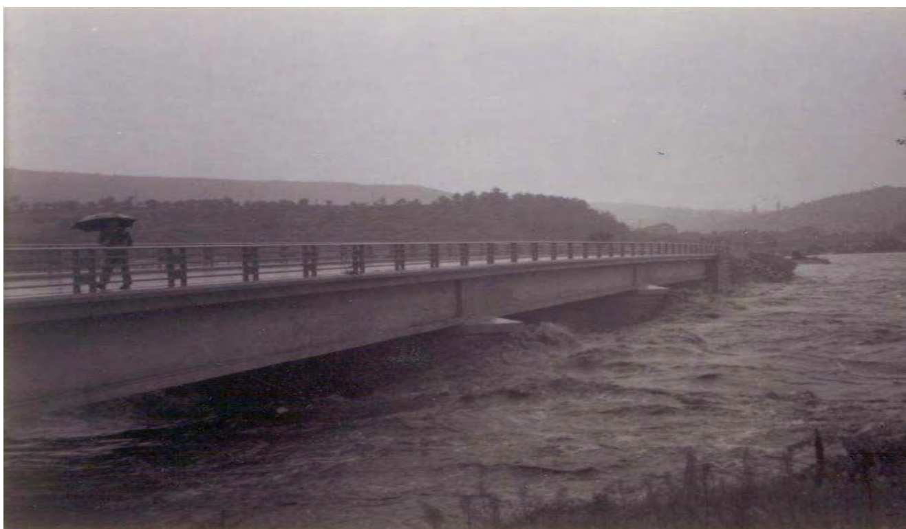
Crue octobre 1958 - amont pont de la Beaume
