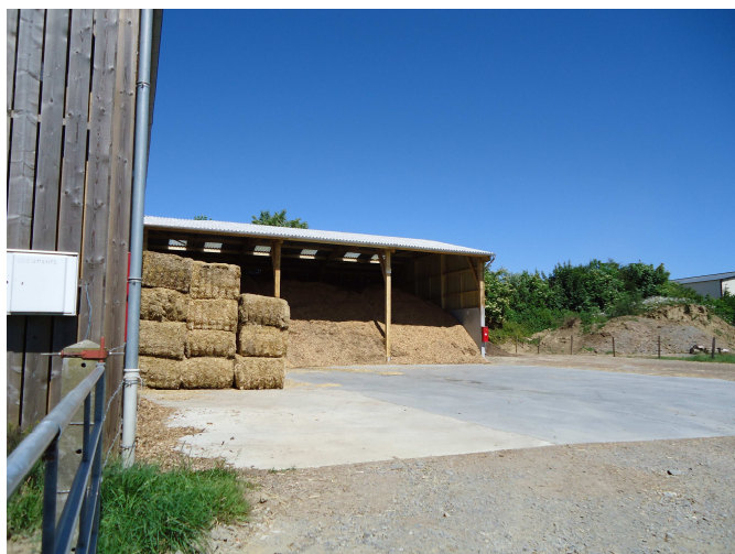
1 – Plateforme de stockage
