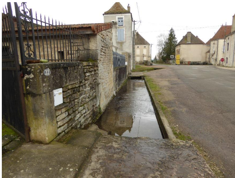
Ru canalisé à Laives
