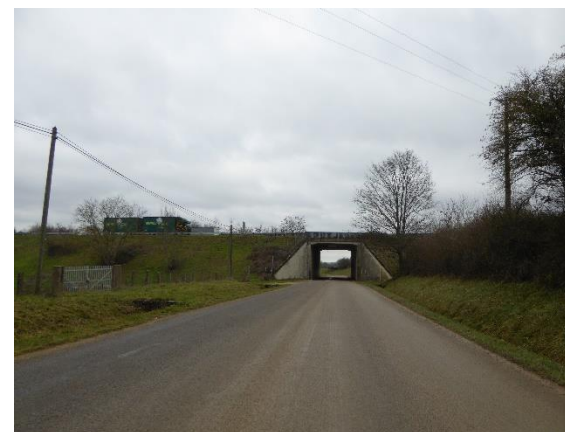
Passage sous l'A6 à Sennecey-le-Grand
