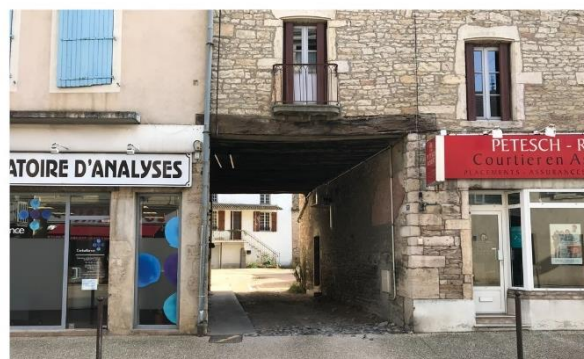
1. Porche d'entrée donnant sur la rue principale, Sennecey-le-Grand
