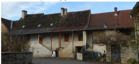
Maisons vigneronnes à galerie, Curtil-sous-Burnand
