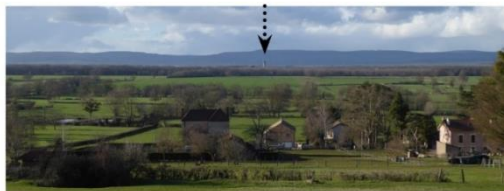
Nanton, château d'eau de La Chapelle de Bragny
