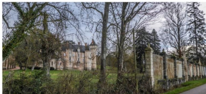
Château de Bresse-sur-Grosne, partiellement inscrit
