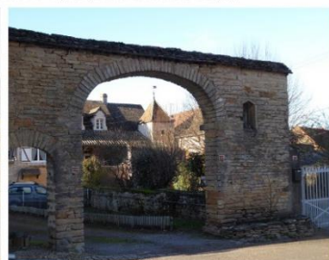
Autres éléments de petit patrimoine, Porche, Nanton
