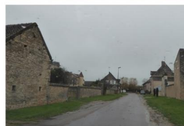
Alternance de bâtis sur rue et de murs, Saint-Cyr
