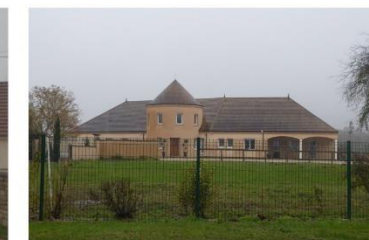
Excentricité, Tourelle et arcades, Saint-Cyr
