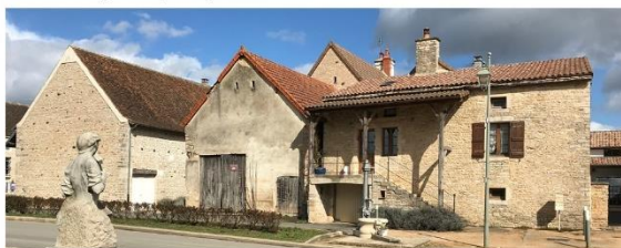
Maison à galerie, Laives
