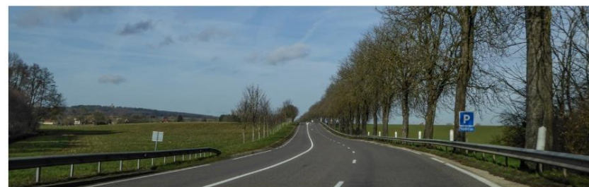
D 906, Entrée Sud de Sennecey-le-Grand
