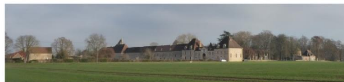
Château de la Ferté, partiellement classé
