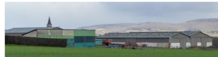
Bâtiments agricoles imposants masquant la vue sur l'église, Champagny-sous-Uxelles, entrée Sud
