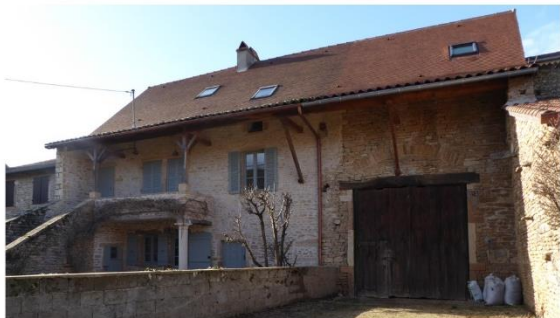
Maison à galerie, Chapaize
