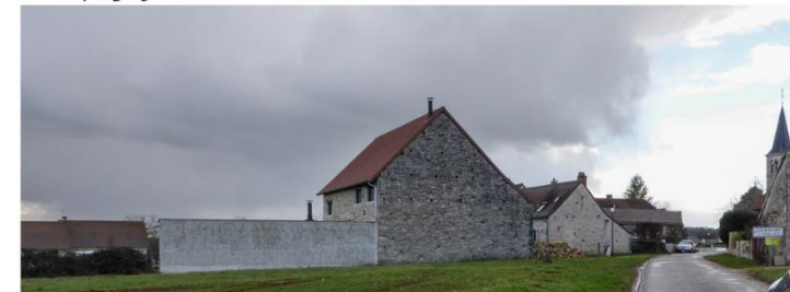
Entrée de ville «mur», Champagny-sous-Uxelles
