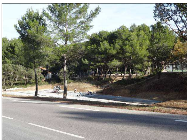
Terrains de tennis en construction
