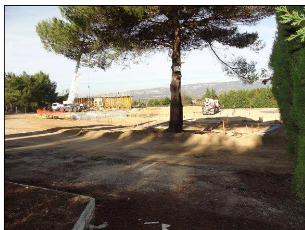
Travaux de restructuration du camping
