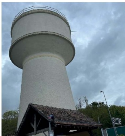
Des études ont été lancées par le Pays de Fontainebleau, pour l'implantation d'un nouveau château d'eau, afin de sécuriser l'approvisionnement JVC/RSM77
