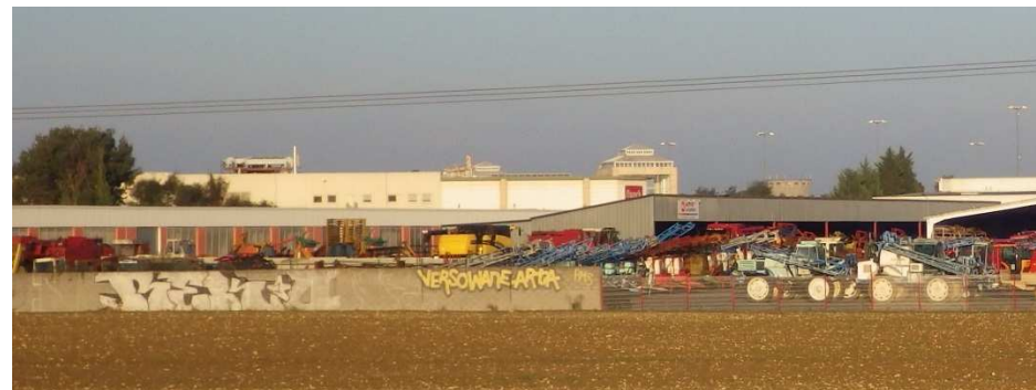
Présence de tags en entrée de ville de Châteauroux depuis la D943 (©Agence MTDA, 2016)
