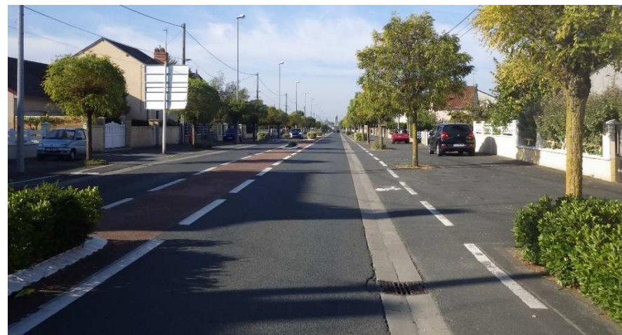
Axe routier aménagé avec l'église en point de chute formant un ensemble qualitatif route d'Issoudun à Déols (©Agence MTDA, 2016)
