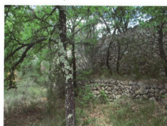
Photo 15. Mur de soutènement
