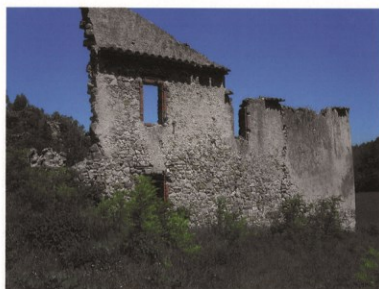
Photo 8. Bâtiment 1. Façade ouest
