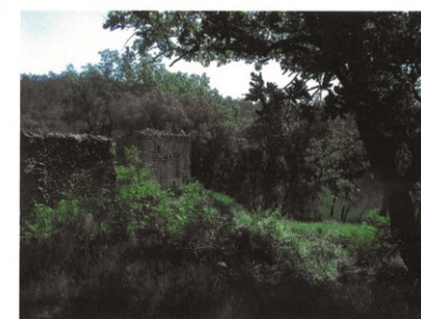
Photo 16 Bâtiments 2. Façade nord
