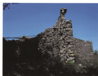
Photo 13. Bâtiment 2. Façade ouest
