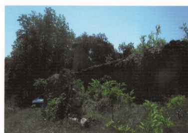
Photo 15. Bâtiment 2. Façade ouest
