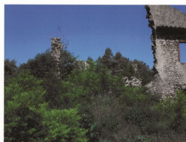
Photo 9. Bâtiment 1. Façade ouest
