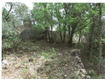
Photo 14 . Mur de soutènement
