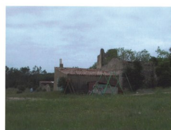
Photo 2. Vue de près façade est
