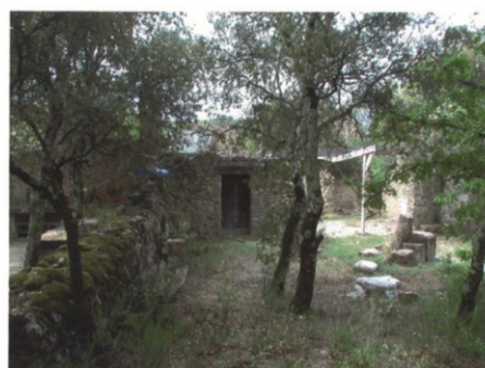
Photo 2. Bâtiment principal . Façade nord
