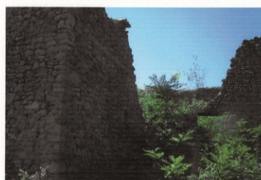
Photo 7. Bâtiment 1 . Façade sud
