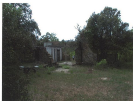
Photo 1. Bâtiment principal . Façade nord
