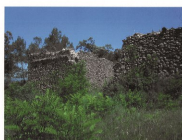
Photo 5. Bâtiment 1 . Façade nord
