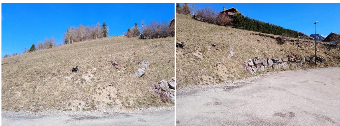
Vue du site depuis le virage-enrochement en amont du site stabilisant les sols mais peu qualitatifs
