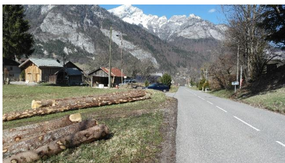
Accès au site depuis la RD32
