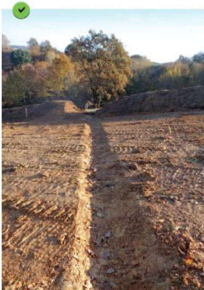
Cunettes successives, sur une piste provisoire de circulation des engins, collectant les écoulements superficiels et les dirigeant vers une zone végétalisée située de part et d'autre de l'emprise du chantier. Les points de rejet sont munis de dispositifs anti-érosion.
