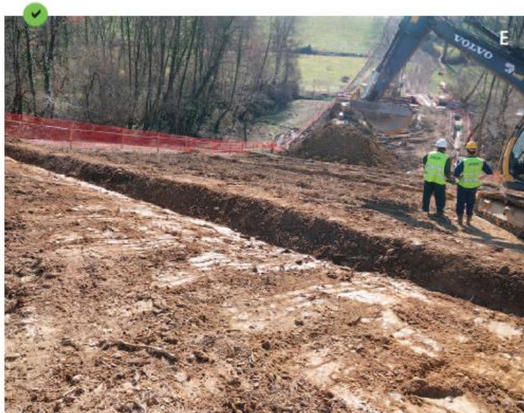
Cunettes successives, sur une piste provisoire de circulation des engins, collectant les écoulements superficiels et les dirigeant vers une zone végétalisée située de part et d'autre de l'emprise du chantier. Les points de rejet sont munis de dispositifs anti-érosion.
