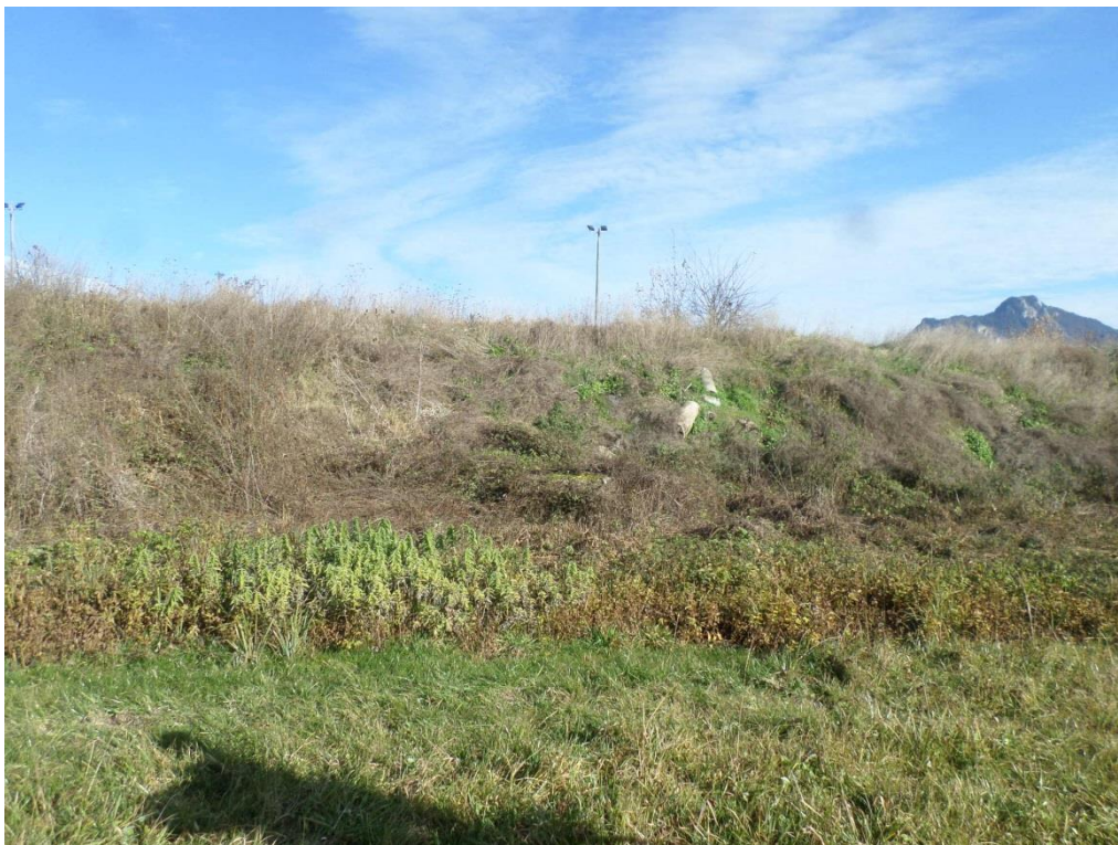
Mur de remblai (Epode, novembre 2020)
