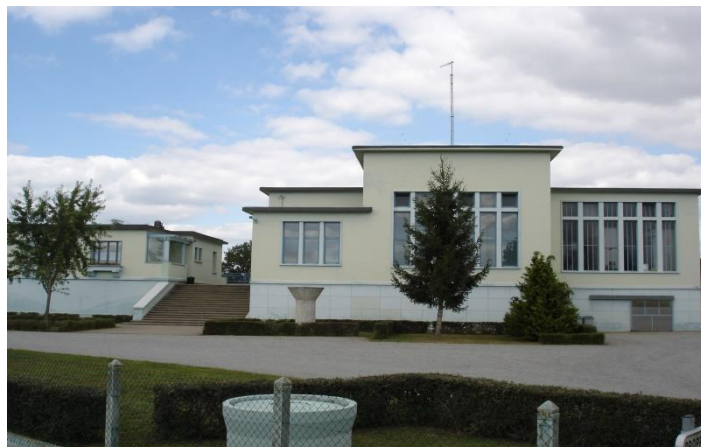
Station de captage et pompage de Contigny
