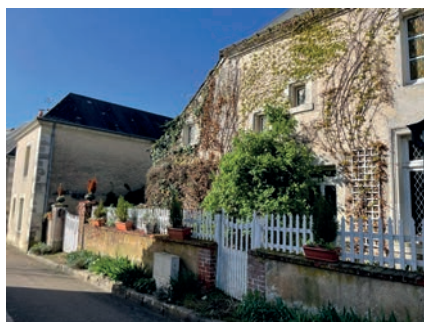
Façades végétalisées à Bueil-en-Touraine, Source : Cittanova
