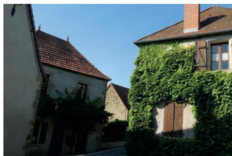
Façades végétalisées à Bert, Source : Cittanova
