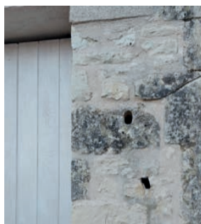
Trous dans murs en moellons
