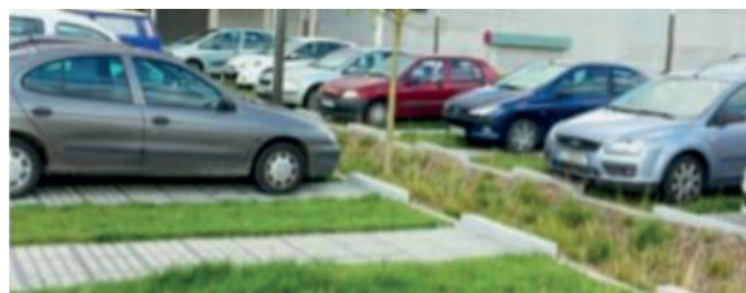
Noue végétalisée avec infiltration gravitaire du ruissellement
