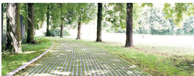
Revêtement de circulation douce semi-perméable
