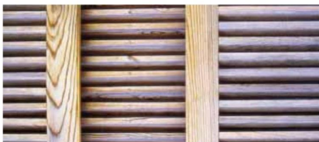
Bois posé à claire-voie
