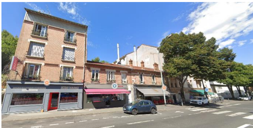
Vue du tronçon 484-536 avenue Roger Salengro
