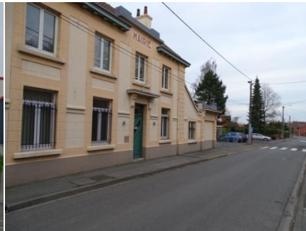
Mairie Rue de la Mairie
