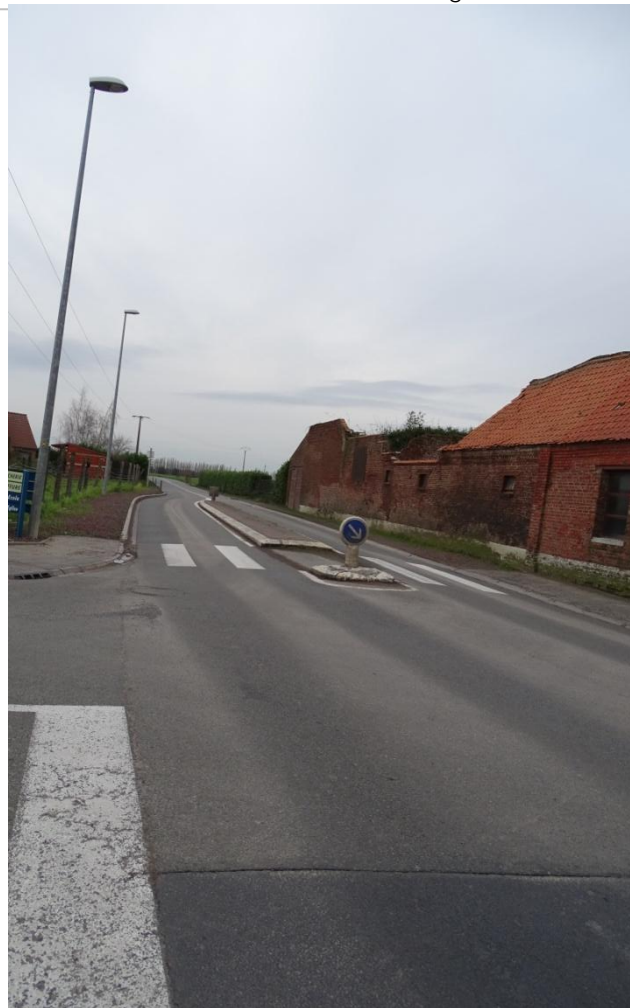
Aspect linéaire de la RD62
