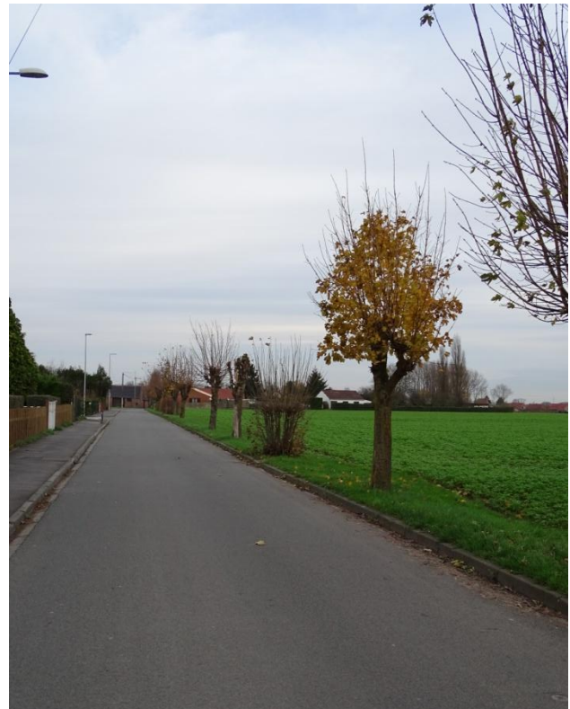
Aspect linéaire de la rue de la Mairie
