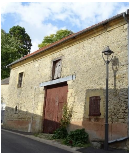
Type 1 : Les façades en maçonnerie de moellons rejointoyés et encadrements de baie en pierre de taille. – Exemple 2, rue St Nicolas à Chenay
