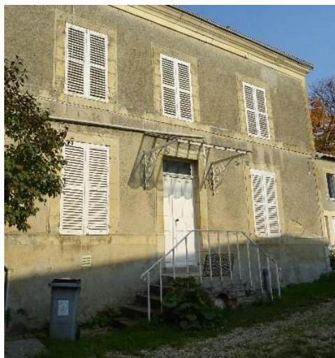
Type 2 : Les façades en maçonnerie enduite et encadrements de baie en pierre de taille - Exemple rue Philibert à Chenay
